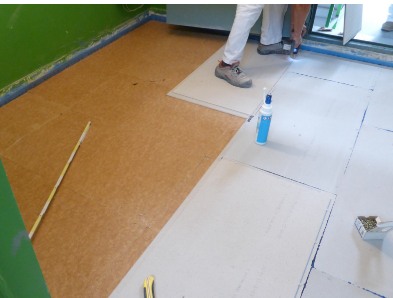
Fig. 3: Esempio di massetto galleggiante a secco
