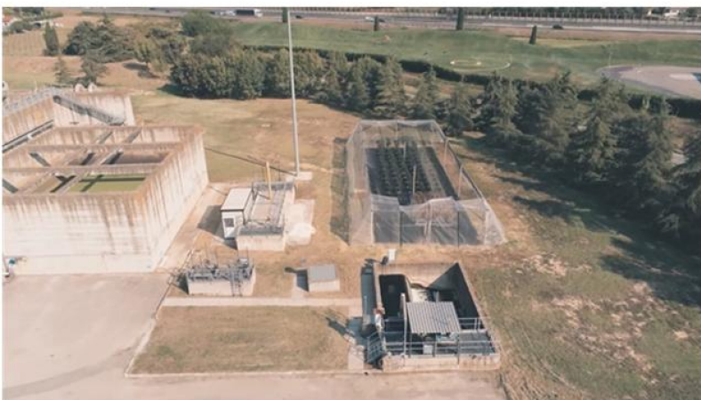
Fig. 3: Parcella pilota prototipale installata nell'impianto di depurazione di acque reflue urbane di Cesena, gestito dal Gruppo HERA S.p.A nell'ambito del progetto VALUECEIN
