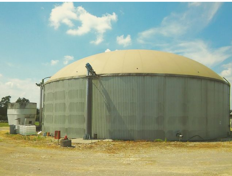
Fig. 2: Impianto di biogas agricolo
