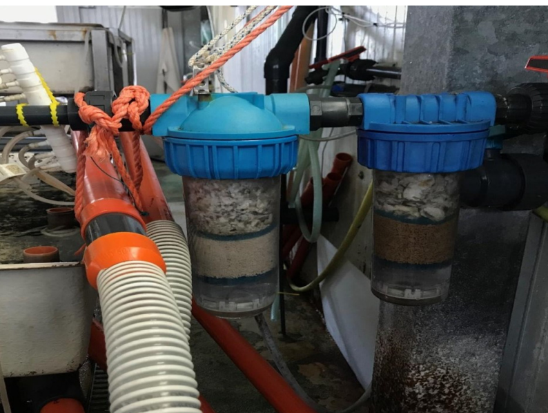
Fig. 2: Filtri ottenuti con capulero di scarto installati presso lo schiuditoio
