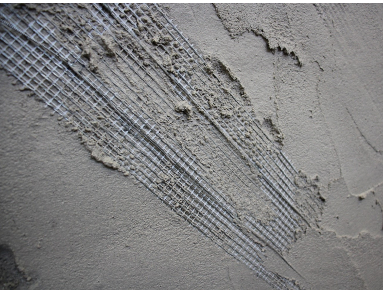
Fig. 2: .Monitoraggio murature storiche per il Restauro e recupero del costruito
