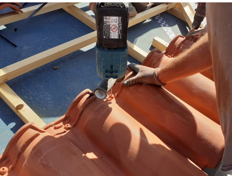
Fig. 3: Installazione di tegola con migliorata permeabilità all'aria
