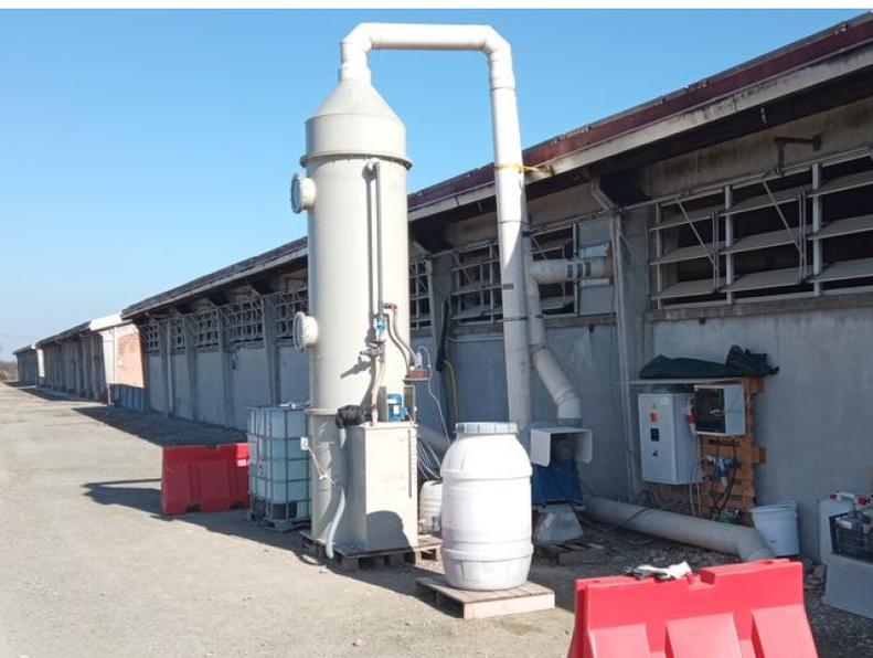
*Fig. 2: Figura 2: Prototipo per ridurre le emissioni azotate in porcilaia attraverso la cattura e il recupero dell'ammoniaca in una soluzione di solfato d'ammonio ad uso fertilizzante.*
