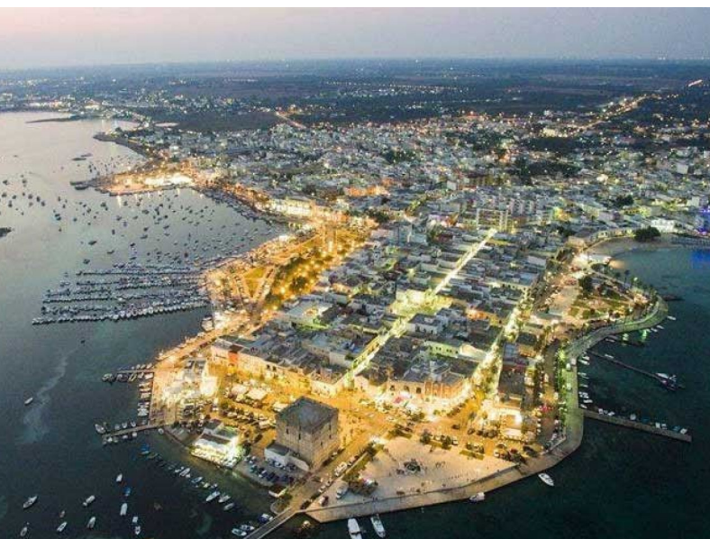
Fig. 3: Vista area del porto della costa ionico-salentina come esempio di applicazione
