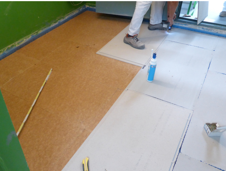
Fig. 3: Esempio di massetto galleggiante a secco
