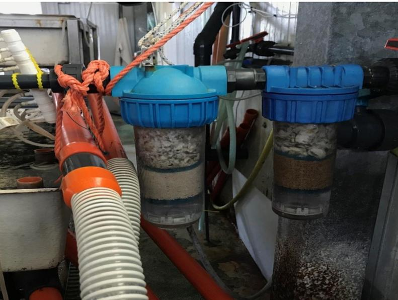
Fig. 2: Filtri ottenuti con capulerio di scarto installati presso lo schiuditoio
