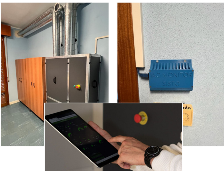
Fig. 3: Armadio Sisto (sx), sistema IAQ-Sana Domi (dx), dashboard Sana Domi (bottom)
