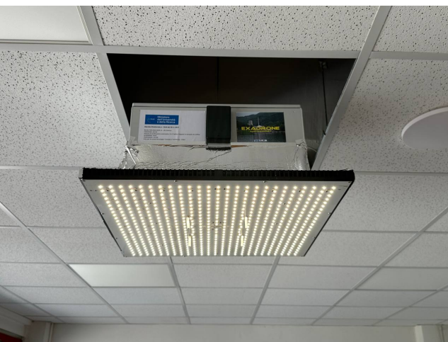
Fig. 3: SAVE in versione lampada bivalente da soffitto con radar laterali di sicurezza.
